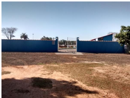
Figura 36: Entrada do Cemitério Municipal - Fonte: Autor
