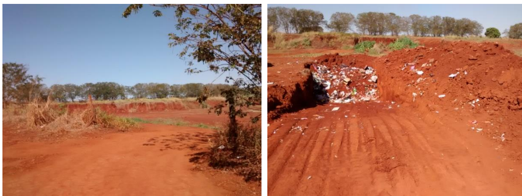
Figura 06 e 07: Aterro sanitário em valas - Fonte: Autor
