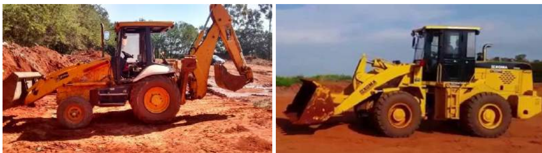
Figura 35 e 36 - Máquinas utilizadas no aterro sanitário.
