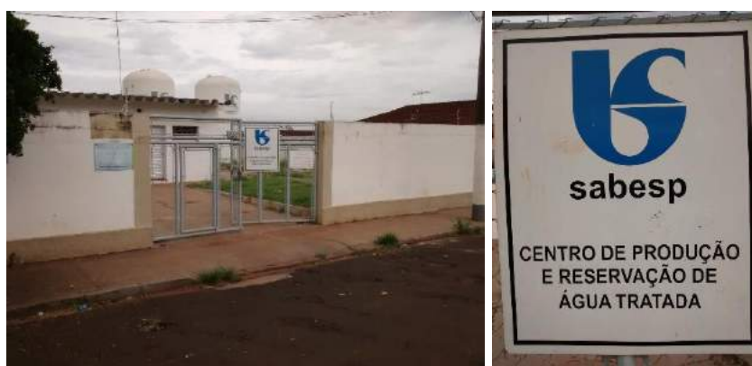
Figura 9 e 10 - Vista do Sistema de Produção, Tratamento, Reservação e Distribuição de Água Tratada e Placa de Identificação.
