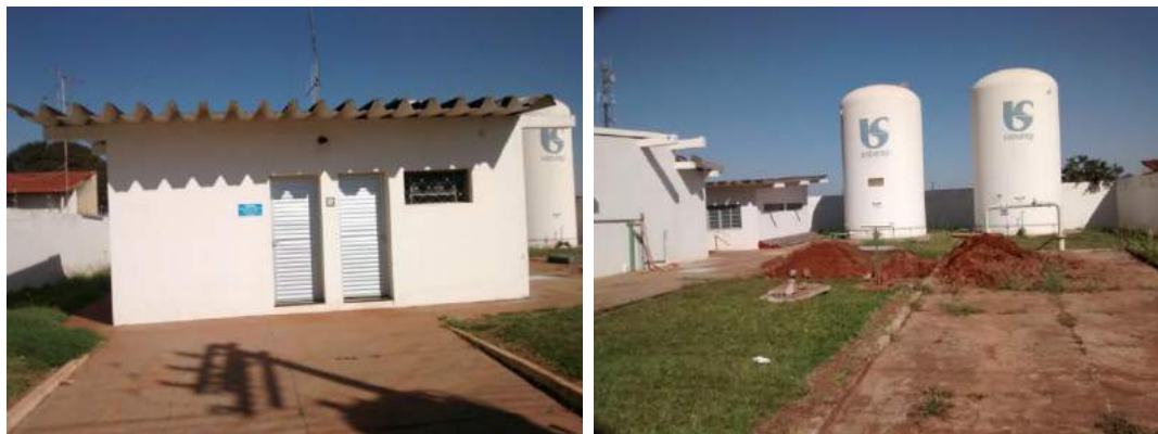
Figura 53 e 54 - Centro de Produção e Reservação de Água Tratada.
