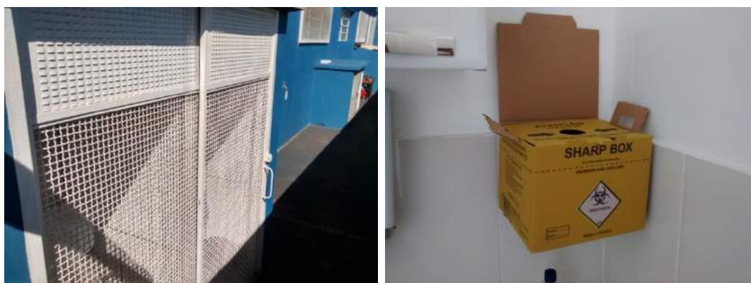
Figura 51 e 52 - Local de armazenamento dos resíduos de saúde.
