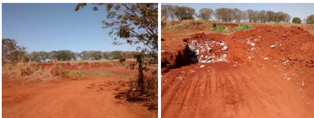
Figura 37 e 38 - Aterro sanitário em valas.
