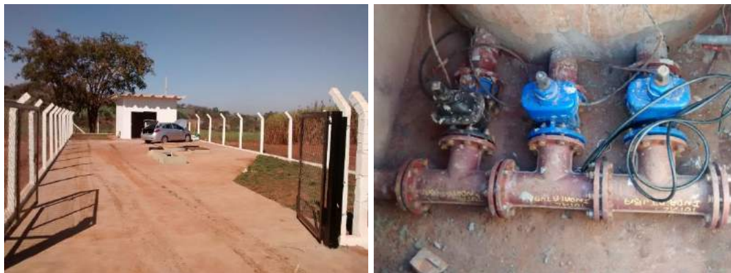
Figura 18 - Estação Elevatória em construção e conjunto de bombas.
