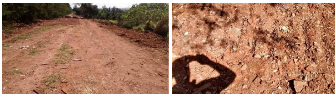
Figura 45 e 46 - Uso dos resíduos da construção civil na recuperação de estradas rurais.
