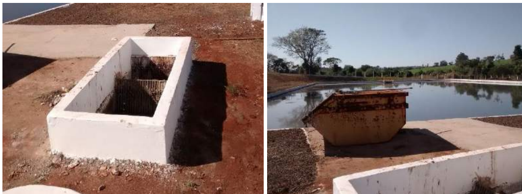
Figura 21 e 22 - Tratamento preliminar e local de deposição da limpeza das grades.
