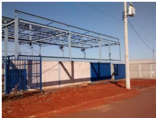
Figura 67 - Indústria em fase de instalação.
