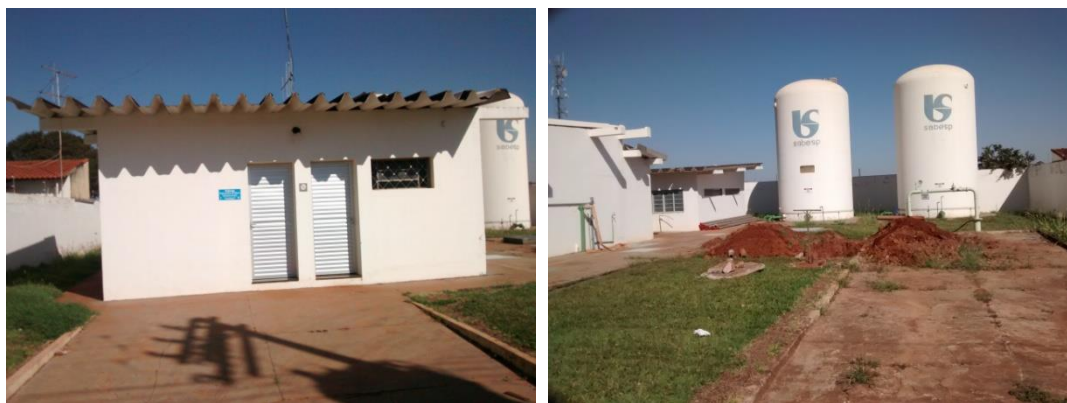
Figura 26 e 27: Centro de Produção e Reservação de Água Tratada - Fonte: Autor
