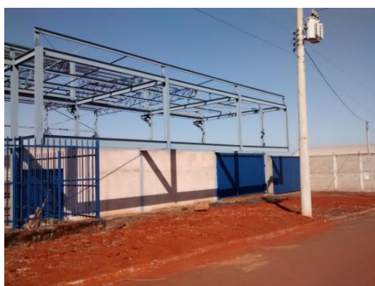
Figura 43: Indústria em fase de instalação - Fonte: Autor
