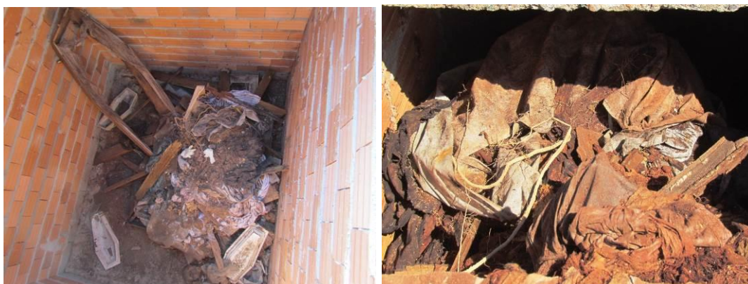
Figura 39 e 40: Exemplo de local adequado para deposição de mortalhas e restos mortais, Este material é depositado evitando-se a queima tão usual nos cemitérios - Fonte: Autor
