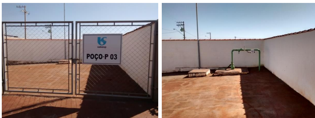
Figura 29 e 30: Poço de captação de água - Fonte: Autor
